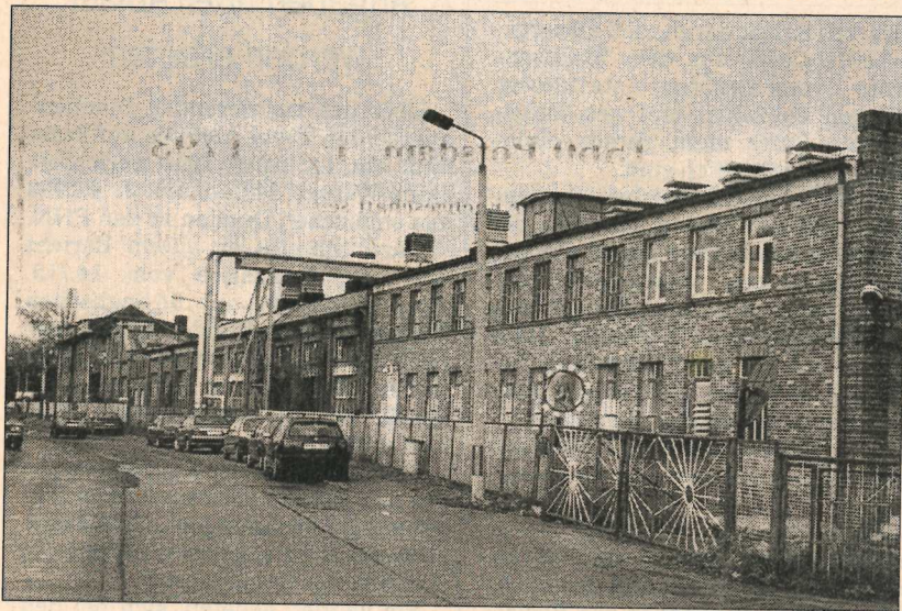
Die um 1890 entstandenen Gebäude des Vulkanfiberwerkes in Werder sollen auf Antrag des Denkmalschutzes in die Denkmalliste aufgenommen werden.
